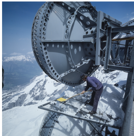
Abb. 5: Parabolantenne auf dem Jungfraujoch im Einsatz für eine Bündelfunkstrecke.
